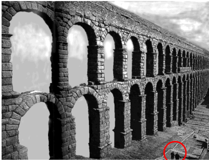
Les merveilles de la voûte romaine : l'aqueduc de Ségovie (Espagne).
